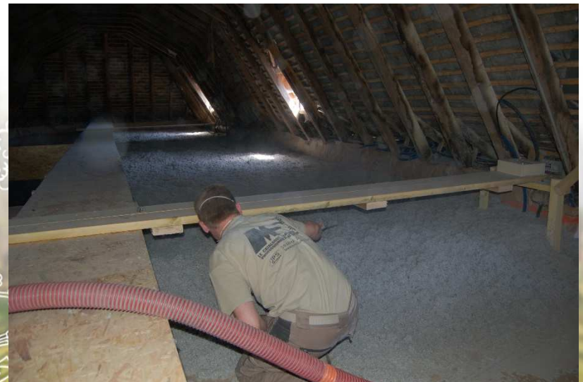
En soufflage de combles
